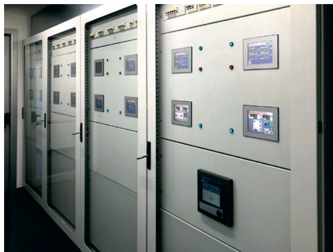
Фото 7. Пульт управления климатической камерой. В камере установлены принтеры, есть возможность задать рабочую температуру от +10 до +45 °С, влажность от 15% до 90%
